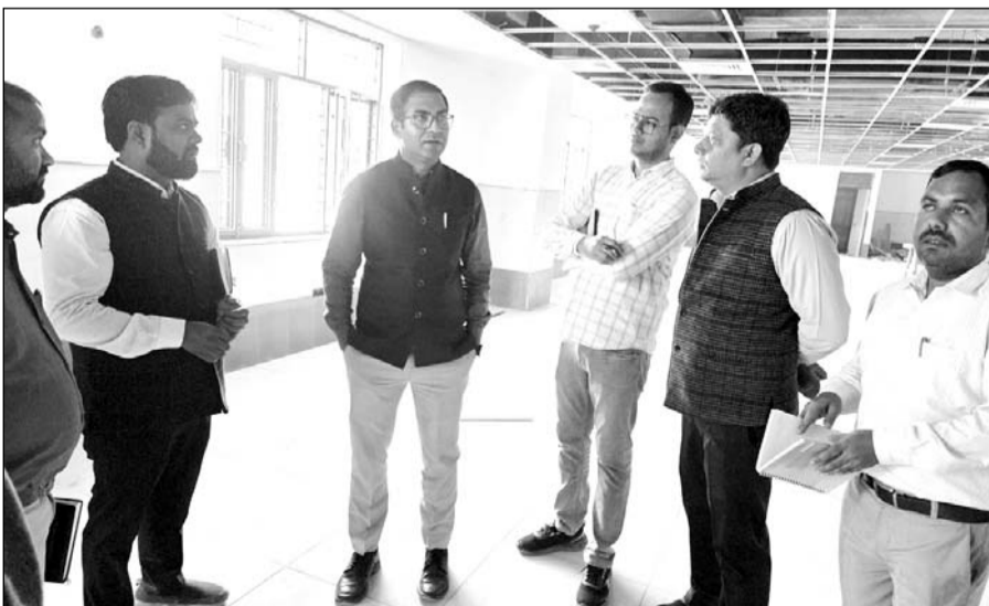
जिला कलेक्टर डॉ अमित यादव ने आरबीएम अस्पताल के निर्माण कार्य का निरीक्षण किया।
