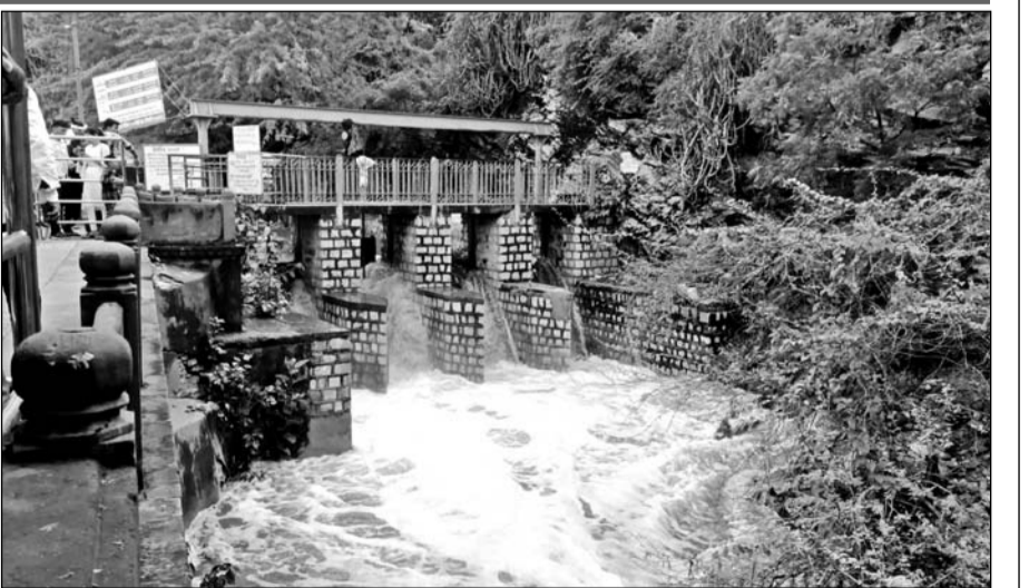
आनासागर के चैनल गेट को खोलकर झील के पानी की निकासी की जा रही है।
