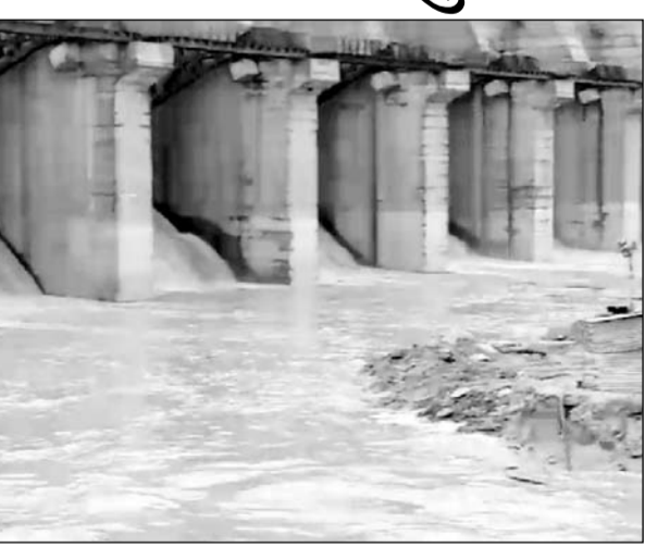
शनिवार सुबह बनास नदी में पानी की आवक बढ़ने से लबालब भरकर कॉपर डेम ओवरफ्लो हो गया।
