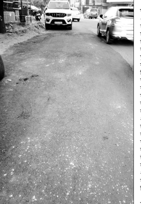
पृथ्वीराज नगर क्षेत्र की कॉलोनियों और मुख्य मार्ग पर हाल ही में जे.डी.ए. द्वारा किए गए पेचवर्क में डामर की मोटी परत चढ़ाकर पुरानी सड़क का अलाइनमेंट ही बिगाड़ दिया गया है।
