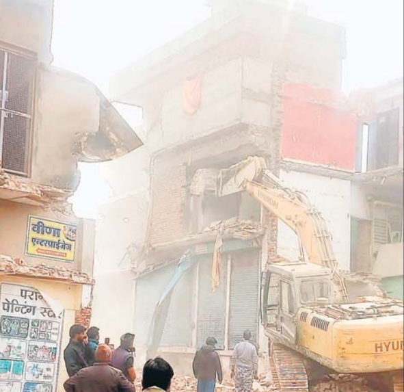
कोटपूतली नगरपालिका ने आज़ाद चौक पर सड़क किनारे बनी इमारतों और दुकानों को तोड़ने की कार्रवाई की।
