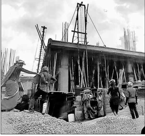
अवैध निर्माण की 20 सितंबर 2021 की निर्माणाधीन तस्वीर।
