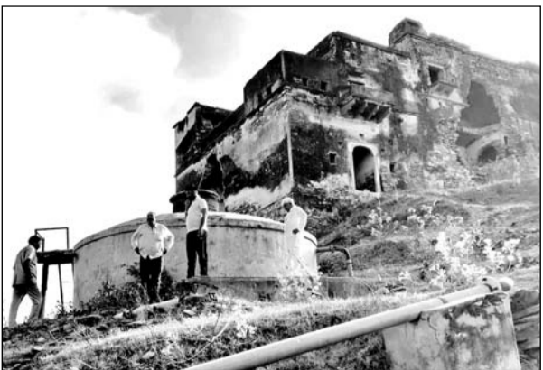
पहाड़ी पर बनी इस टंकी से पानी की सप्लाई की जाती है लेकिन कीड़े, मकोड़े एवं गंदगी होने से ग्रामीण गंदगी पीने को मजबूर है।
