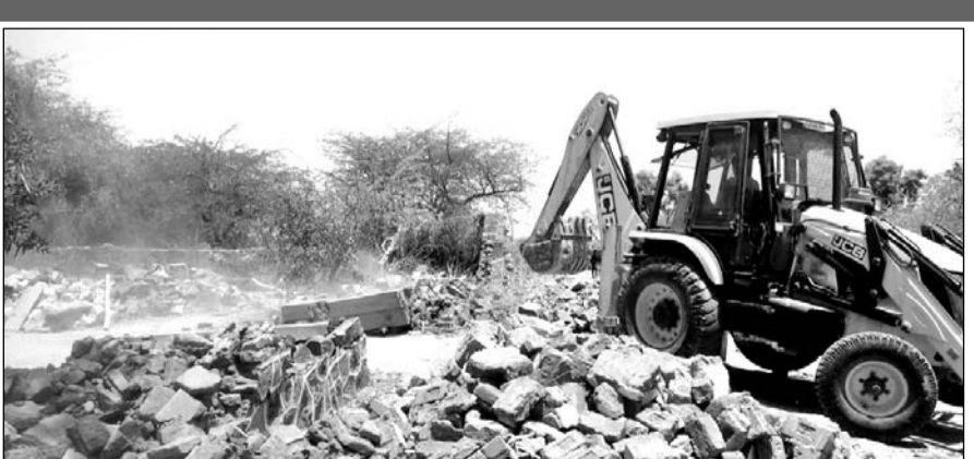
जालौर के निकट ओडवाड़ा में पुलिस व प्रशासन ने जेसीबी से अतिक्रमण हटाने की कार्रवाई की।
