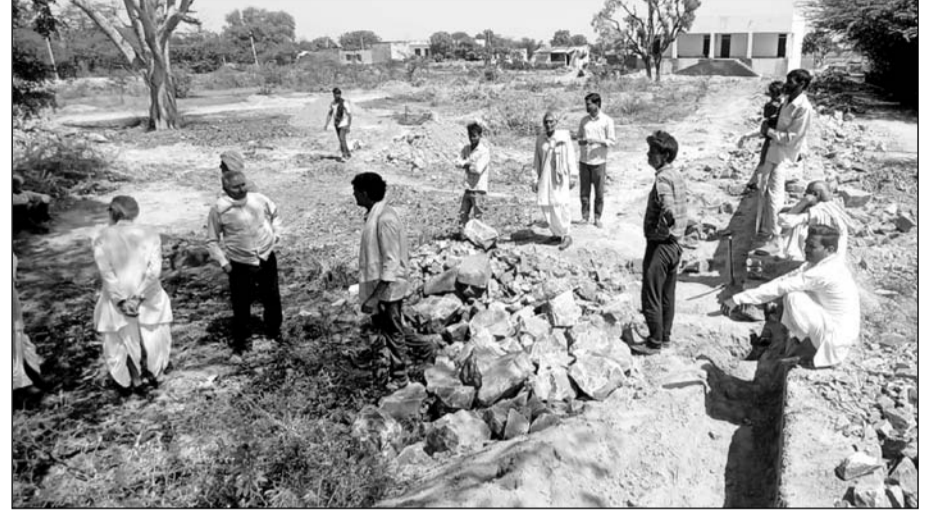
गांव गोपालपुरा में चल रहे विद्यालय की चारदीवारी निर्माण कार्य में घंटिया सामग्री लगाने को लेकर ग्रामीणों ने निर्माण कार्य बन्द करवाया।
