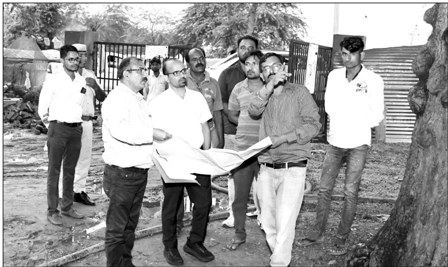
जिला कलक्टर काना राम ने हम्मीर ब्रिज के चौड़ाईकरण एवं विस्तारीकरण कार्य का निरीक्षण कर निर्माण की प्रगति का जायजा लिया।
