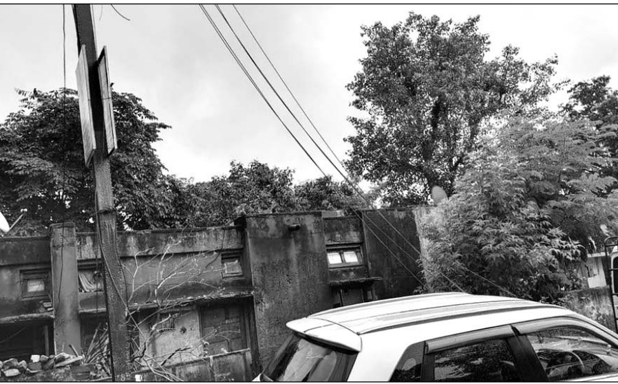
खेतड़ीनगर की सोफिया स्कूल के सामने बिजली लाइन में फाल्ट आने से बिजली के तार टूटकर गिर गए।
