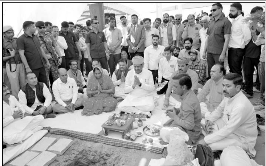
लोकसभा अध्यक्ष ओम बिरला व केशवरायपाटन विधायक चन्द्रकांता मेघवाल ने स्पोर्ट्स कंप्लेक्स निर्माण का भूमि पूजन किया।
