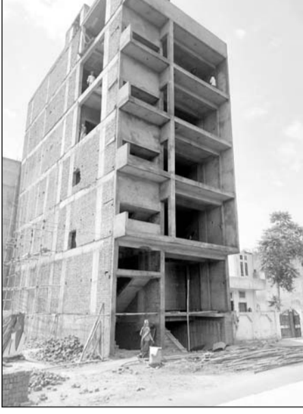
भूखंड संख्या 83/150 पर 6 मंजिला निर्माण
