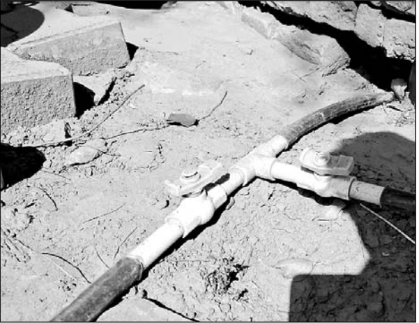
झुंझुनूं जिले के शिवपुरा गांव में हरियाणा के लोग पाइप लाइन डालकर पानी की सप्लाई करते हैं।
