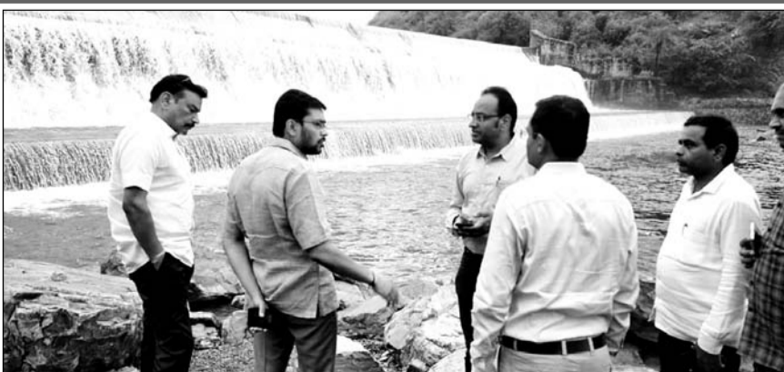
जैतपुरा और गोवटा बांध का भीलवाड़ा कलेक्टर व पुलिस अधीक्षक ने निरीक्षण किया।
