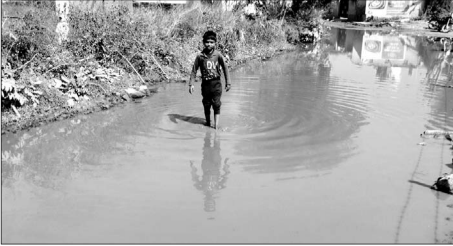
ग्राम ललाना मांजूकोट होकर गुजर रही क्षतिग्रस्त सड़क में पानी भरा हुआ है।
