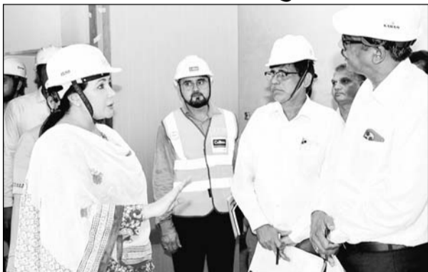
दिया कुमारी ने सोमवार को दिल्ली में निर्माणाधीन राजस्थान हाउस का निरीक्षण किया।
