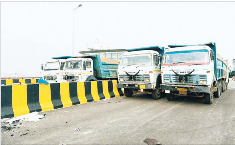
राजधानी जयपुर की सबसे लंबी सोडाला एलिवेटेड रोड पर मंगलवार से लोड टेस्टिंग का काम शुरू हो गया है।
