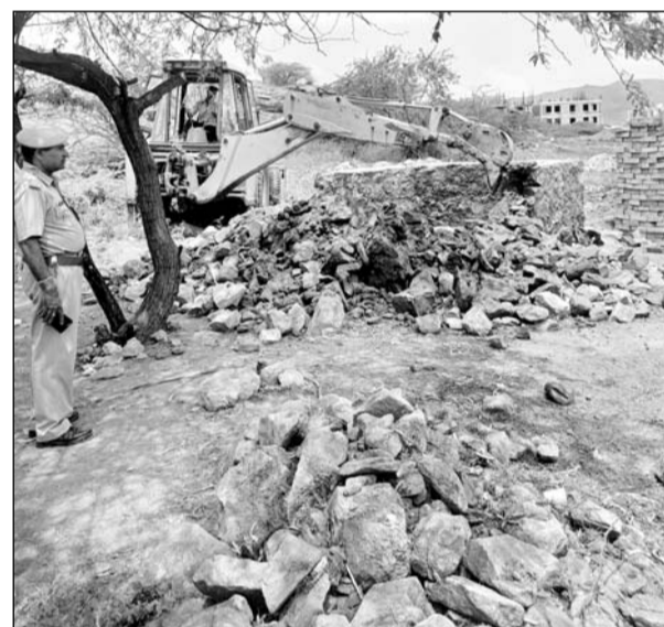
लोहागल ग्राम के खसरा संख्या 1050 पर हो रहे नवीन निर्माण को जेसीबी की सहायता से ध्वस्त किया।
