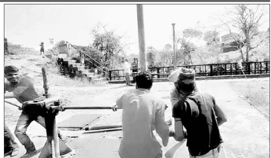
देवास स्टेज प्रथम का पानी अलसीगढ़ डेम से पीछोला झील में छोड़ा गया।
