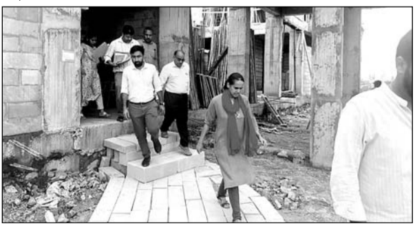
जेडीए आयुक्त आनन्दी ने निर्माणाधीन आईपीडी टावर का निरीक्षण किया।
