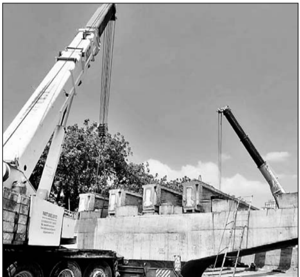
जयपुर-दिल्ली एवं जयपुर-सवाई माधोपुर रेलमार्ग पर आर.ओ.बी. सिविल लाईन्स का निर्माण करवाया जा रहा है।
