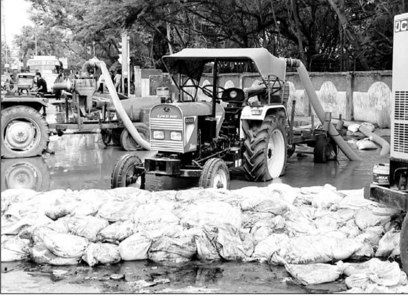
चौमूं पुलिया से झोटवाड़ा की ओर जाने वाले मार्ग पर जे.डी.ए. प्रशासन ने पिछले दिनों जहां सीमेंट सड़क बनाई थी, वहां सीवर लाइन क्षतिग्रस्त हो गई। हालात इतने बिगड़े कि 5 मड पंप लगाकर सड़क से सीवर का पानी हटाना पड़ा, साथ ही आर्मी एरिया की दीवार के पास सड़क की खुदाई भी करनी पड़ी।
