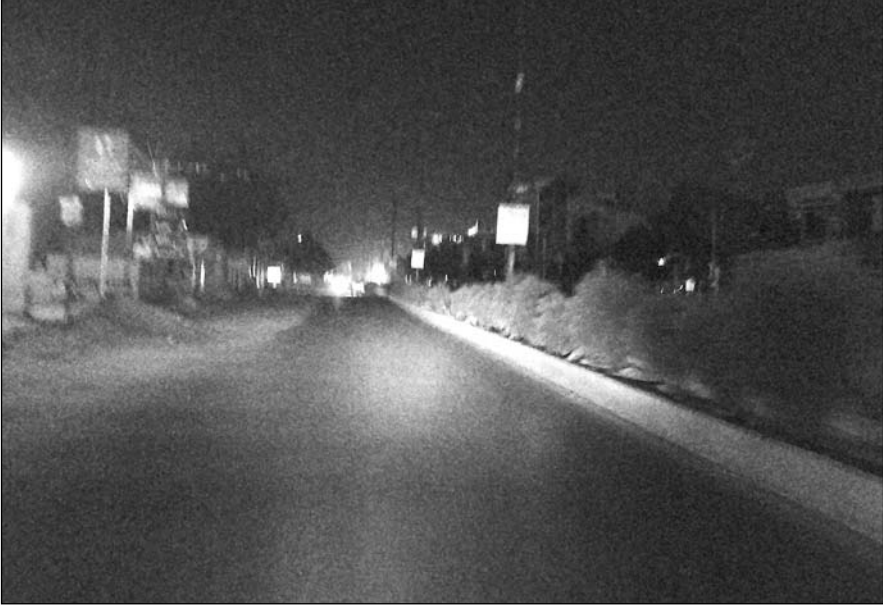
मानसून सिर पर है, लेकिन झोटवाड़ा सर्किल से 2०0 फीट पुलिया के बीच मुख्य सड़क पर लगी अधिकांश रोड लाइट्स खराब पड़ी है।
