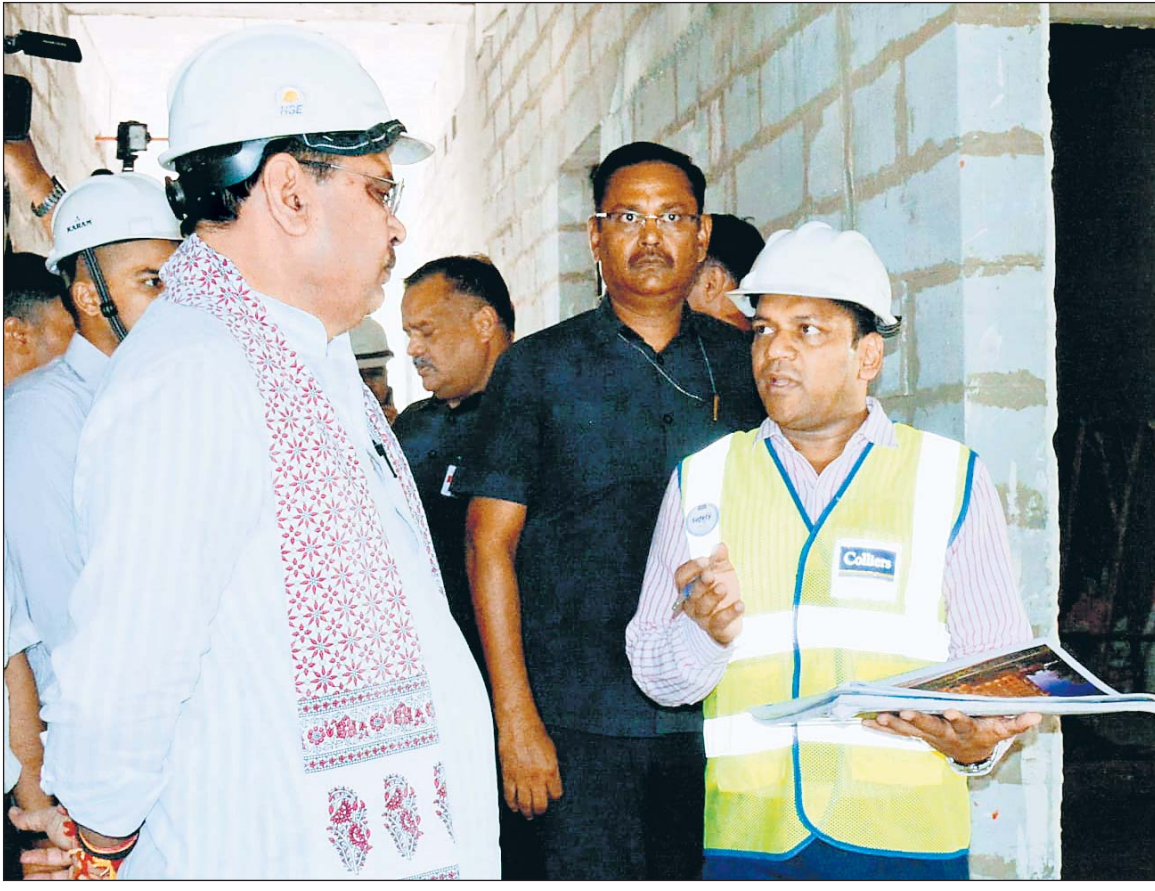
मुख्यमंत्री भजनलाल शर्मा ने सोमवार को दिल्ली में राजस्थान हाउस का दौरा कर नवनिर्माण कार्यों को निरीक्षण किया। मुख्यमंत्री ने कहा कि, भवन निर्माण में राजस्थान की बेजोड़ स्वापक कला का ध्यान रखा जाये। मुख्यमंत्री ने कहा कि, निर्माण कार्यों में गति लाने की जरूरत है, ताकि निर्माण कार्य तय समय-सीमा में पूरा हो सके।
