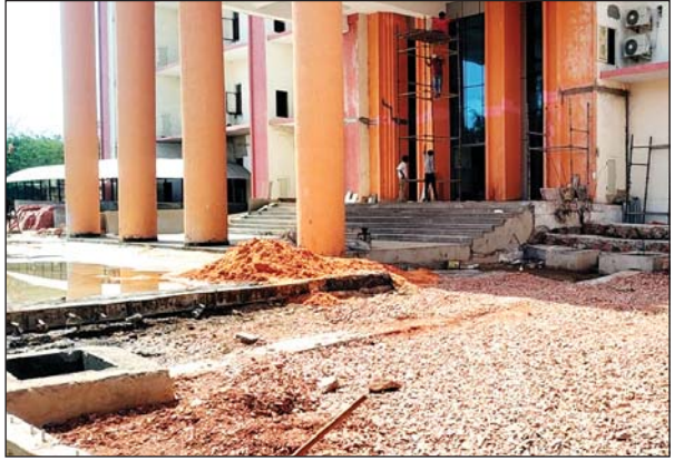
भरतपुर में आर बी एम हॉस्पिटल में पुरानी बिल्डिंग में लगाए गए बेड अब वर्तमान में नहीं हैं, क्योंकि पुरानी बिल्डिंग को तोड़कर अब नई बिल्डिंग बनाई जा रही है।
