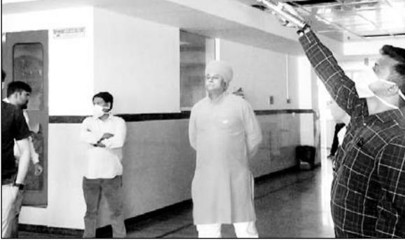
आईआईटी रुड़की के इंजीनियर्स ने पीबीएम अस्पताल में एसएसबी के थर्ड फ्लोर के निर्माण कार्य का निरीक्षण किया।
