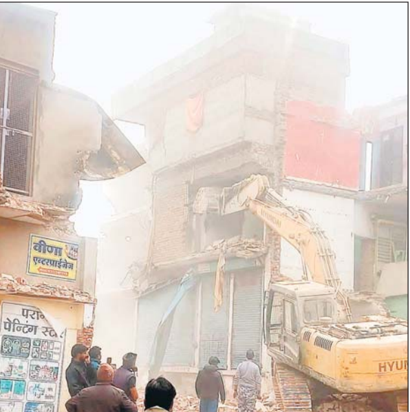
कोटपूतली नगरपालिका ने आजाद चौक पर सड़क किनारे बनी इमारतों और दुकानों को तोड़ने की कार्रवाई की।
