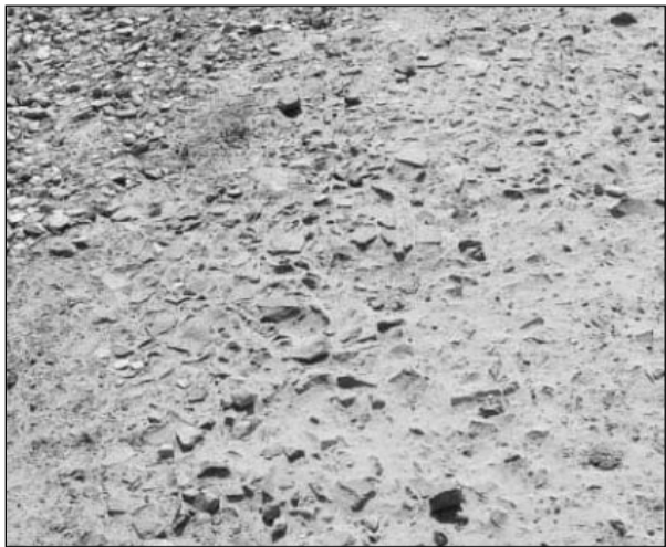
निकटवर्ती भैरुंसर और भोलुसर के बीच पौने 2 किमी. लंबी सड़क टूट जाने के कारण आमजन के लिए जी का जंजाल बनी हुई है।
