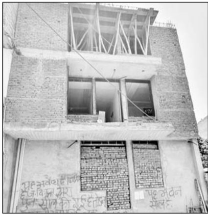
डाल दी। दूसरी मंजिल पर दीवारों और पिल्लरों का निर्माण कर छत डालने के लिए शर्टिंग की जा रही थी। जेडीए की टीम जब रुटीन चैक के लिए वहां पहुंची तो बिल्डिंग में निर्माण कार्य होता दिखा। टीम ने वहां रखे कंस्ट्रक्शन मैटैरियल को जब्त कर इमारत को पुनः सीज किया।
