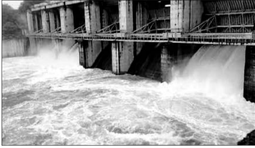
करौली जिले के सबसे बड़े बांध पांचना से पानी की निकासी की जा रही है।
