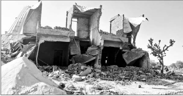
जे.डी.ए. के प्रवर्तन दस्ते ने बुधवार को सांगानेर स्थित ग्राम पवालिां में बसाई जा रही अवैध कॉलोनी में निर्माणाधीन मकानों को ध्वस्त किया।
