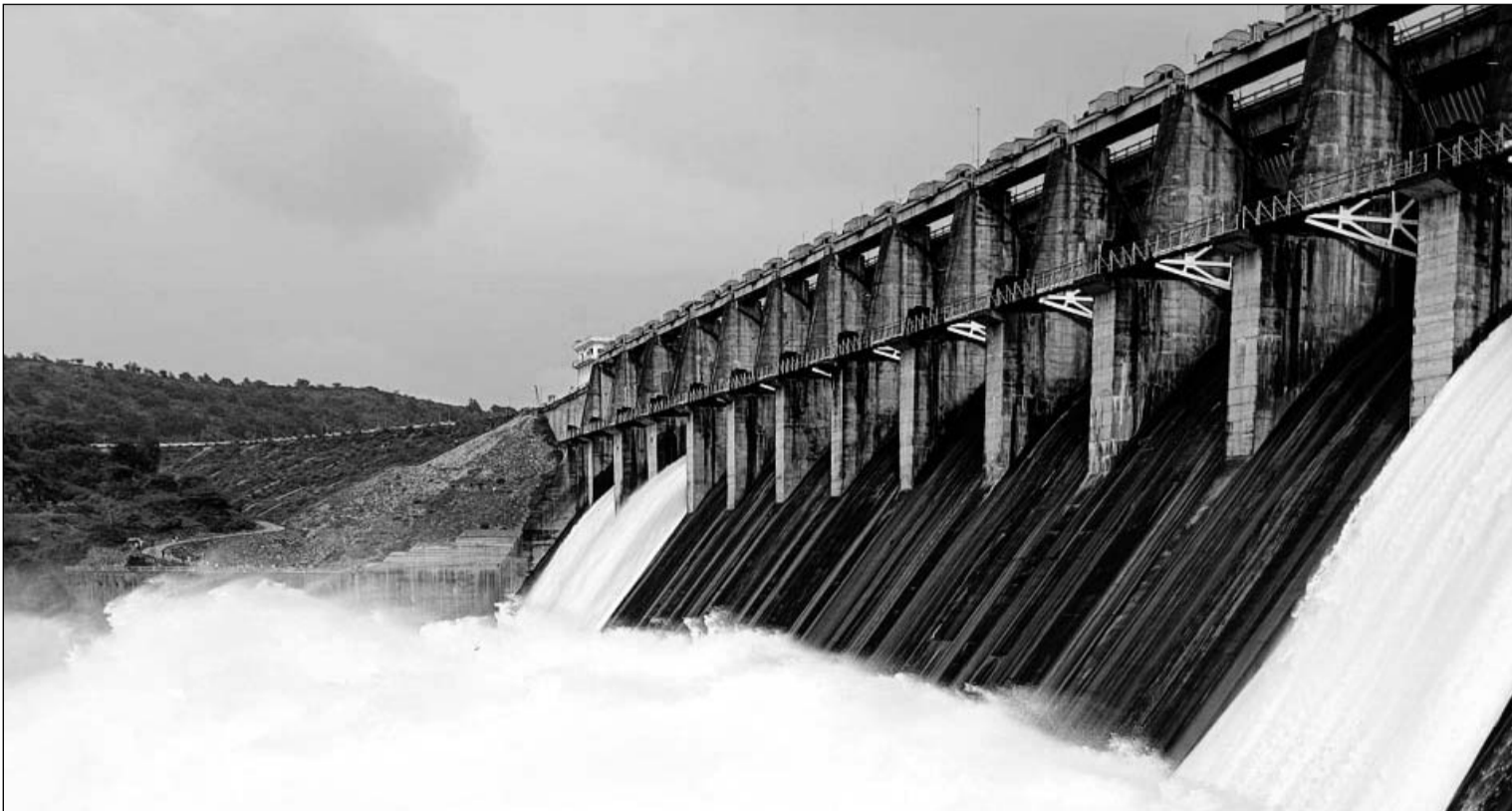
माही बांध के गेट खोलकर पानी की निकासी की जा रही है।
