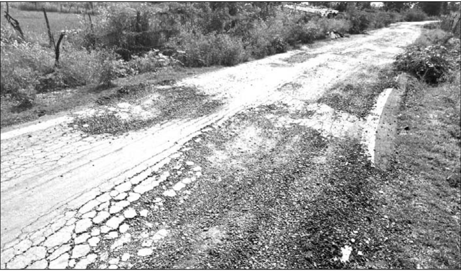
माण्डलगढ़ के दौलपुरा मार्ग पर एक करोड़ की लागत से बनी सड़क डामर एक साल में ही उखड़ गई।
