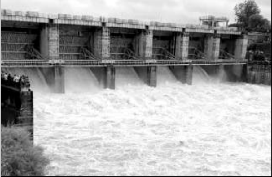
करौली के सबसे बड़े पांचना बांध के चार गेट खोलकर लगातार पानी की निकासी की जा रही है।
