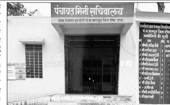
जांच दल ने इंदोली ग्राम पंचायत का आकस्मिक निरीक्षण किया तो भवन पर ताले लटके मिले।
