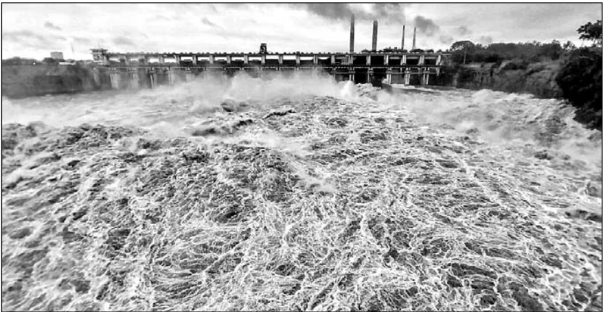
कोटा बैराज के 12 गेट खोलकर पानी की निकासी की गई।
