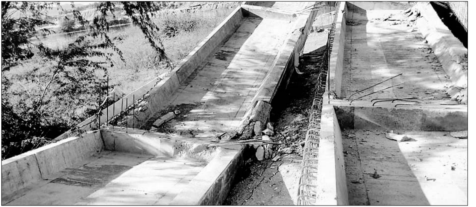
संगमेश्वर पुल का सोमवार को गिरा हिस्सा जो कि घटिया निर्माण की पोल खोल रहा है।
