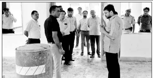
जिला कलक्टर ने लाइब्रेरी निर्माण कार्य का अवलोकन किया।
