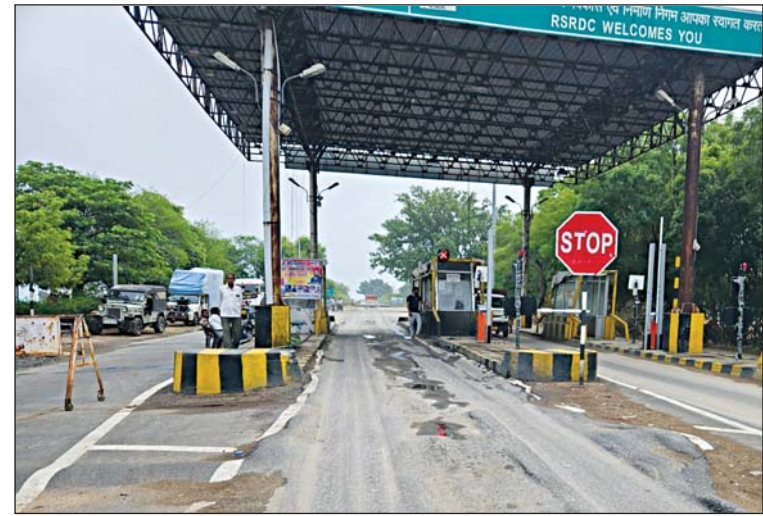
माण्डलगढ़ के त्रिवेणी-जहाजपुर सड़क पर गोपालपुरा टोल प्लाजा पर फर्जीवाड़े से टोल वसूली का मामला सामने आया।
