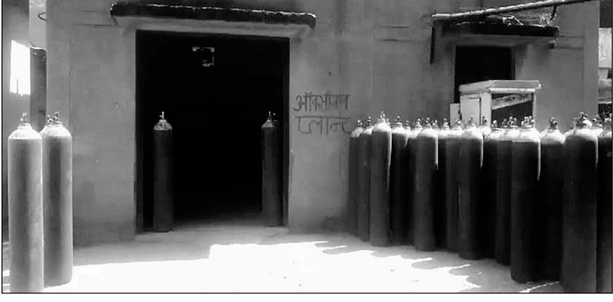
कोटा के अस्पतालों में ऑक्सीजन प्लांट बंद होने के चलते सिलेंडर के जरिए काम चलाना पड़ रहा है।
