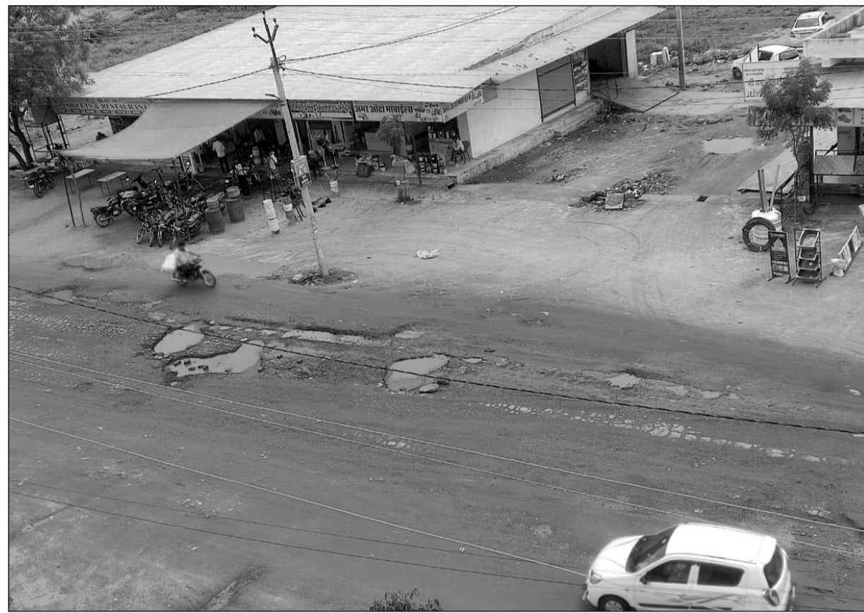
आसींद नगर से गुजर रहे नेशनल हाईवे 158 के रिंग रोड पर पर डामर के नाम पर केवल खड्डे बचे हैं।
