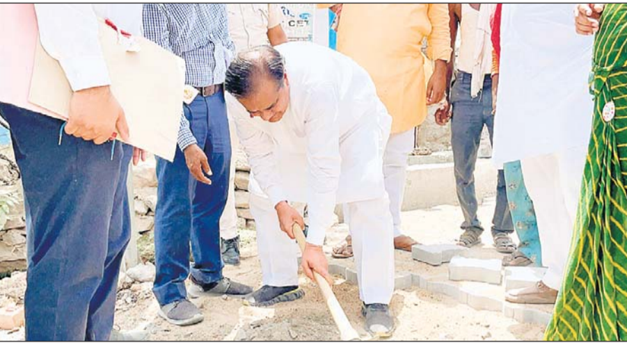
सांसद सुखबीर सिंह जौनापुरिया ने बुधवार को निर्माणाधीन गहलोद पुलिया और शहर में चल रहे सड़कों के निर्माण कार्य का निरीक्षण किया।
