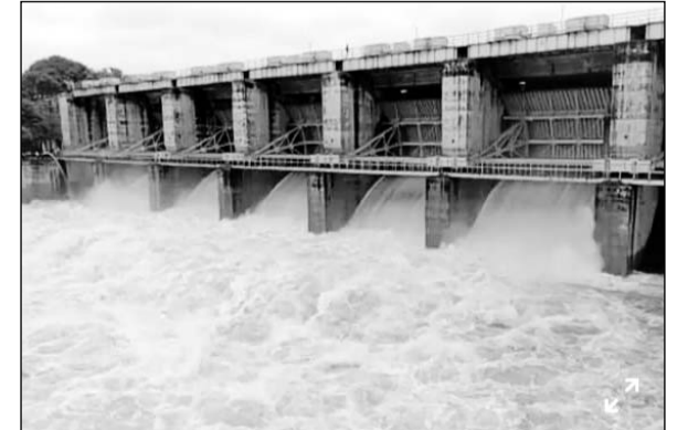
पांचना बांध के पांच गेट खोलकर पानी की निकासी की जा रही है।
