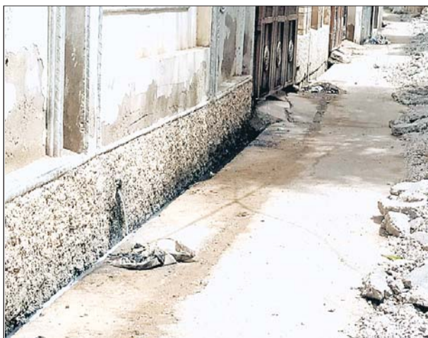
नगरपालिका पावटा प्राणपुरा के वाई 11 स्थित शर्मा कॉलोनी में जलदाय विभाग ने इस कॉलोनी में बनी सड़क को पाइप लाइन बिछाने के नाम पर खोद दिया।
