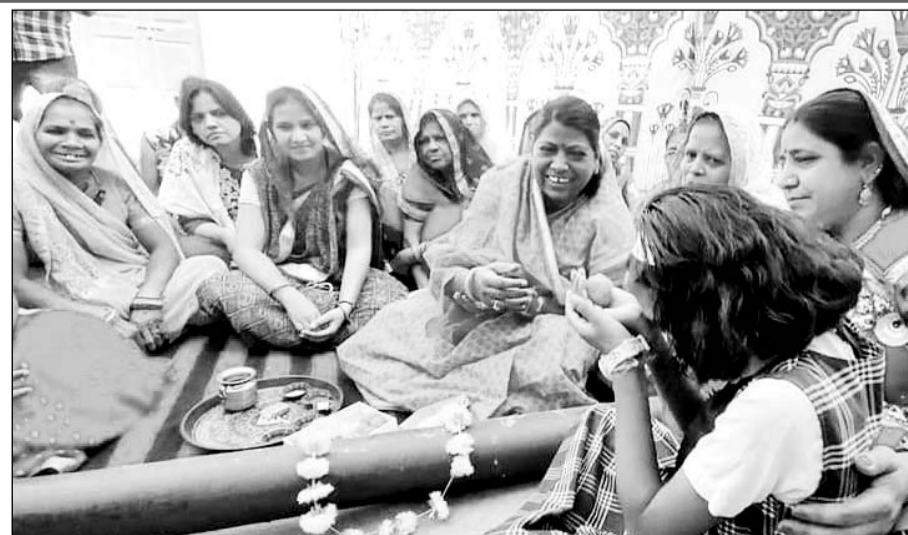
विधायक अनिता भदेल ने स्टील की पेयजल पाइप लाइन का शिलान्यास किया।
